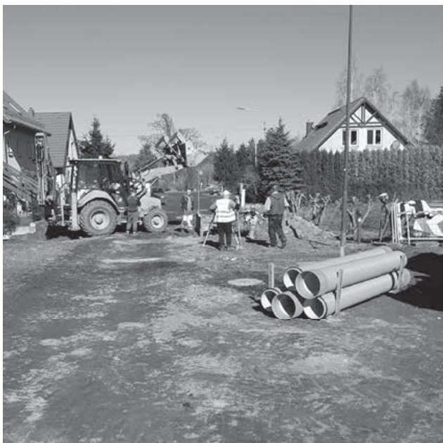
Przebudowa ulicy Reja wraz z budową kanalizacji deszczowej
