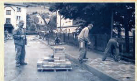
Remont ul. 22-go lipca za środków finansowych UE - 2006 r.
