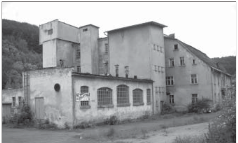
Budynki po fabryce wciąż niszczeją.
