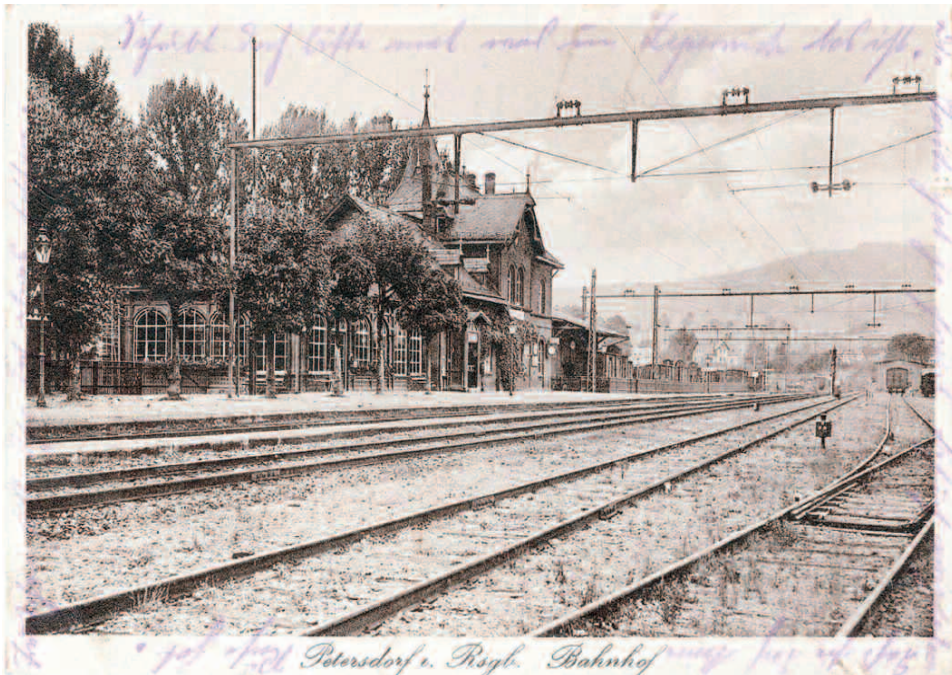
Dworzec zelektryfikowana linia karka z 1932 (zbiory Bekier Sebastian)
