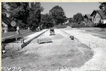
Remont ul. Szklarskiej oraz parkingu sąsiadującego z hutą Julia – 2009 r.
