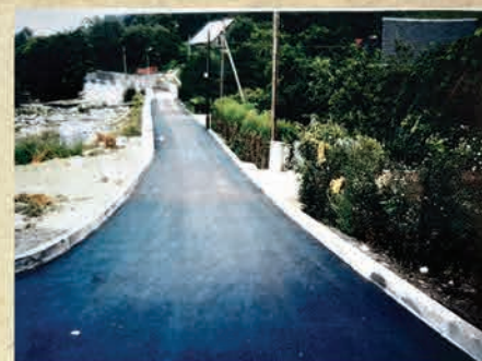
Zakończenie modernizacji ul. Nadrzeczej - 1999 r
