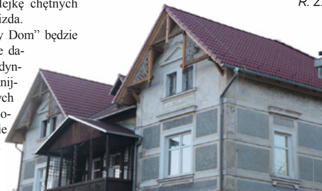
Budynek przy ul. Żymierskiego 36 ma nowy dach.
