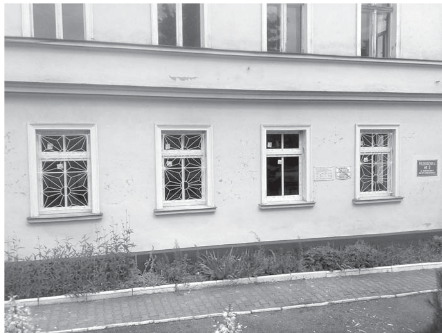
Piechowickie przedszkole zyskało w czasie wakacji nowe okna
