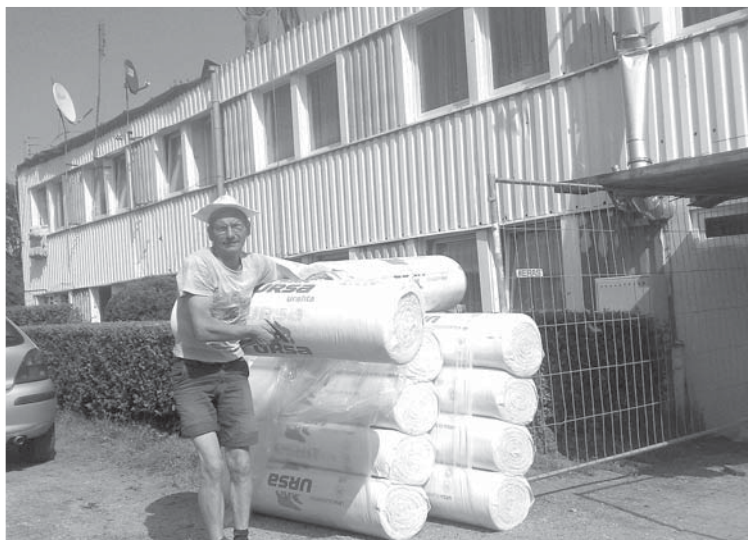
Dach na budynku w Górzyniu będzie jak nowy
